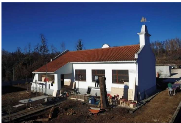
Figura 6 - Reabilitação da antiga escola de Figueira
