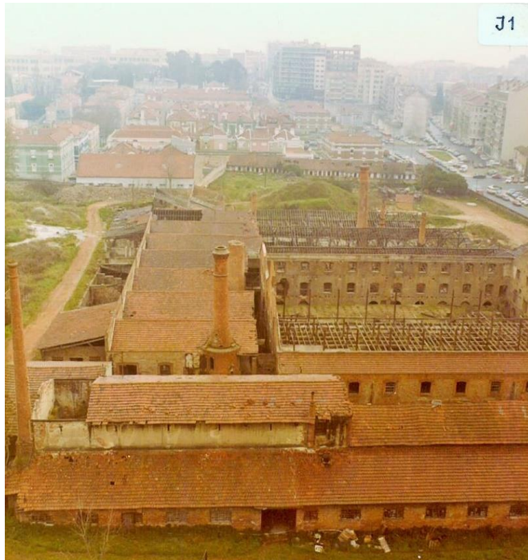
Figura 3 – Complexo da Fábrica Cerâmica Lusitânia
