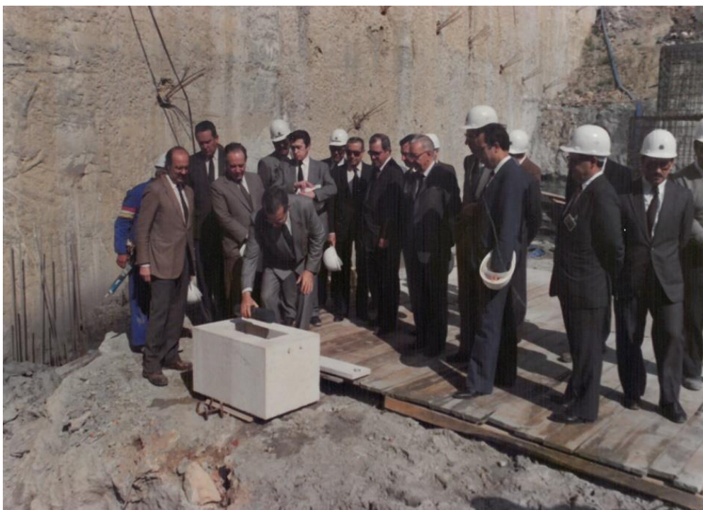
Figura 6 – Lançamento da 1. a pedra: colocação do documento
