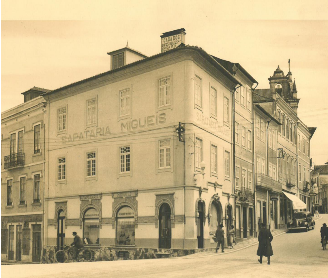
Figura 8 - Terreno para a futura construção do edifício da filial de Aveiro, confrontava a norte com a rua Clube dos Galitos e a sul e poente, com a rua Gustavo Ferreira Pinto Basto.
