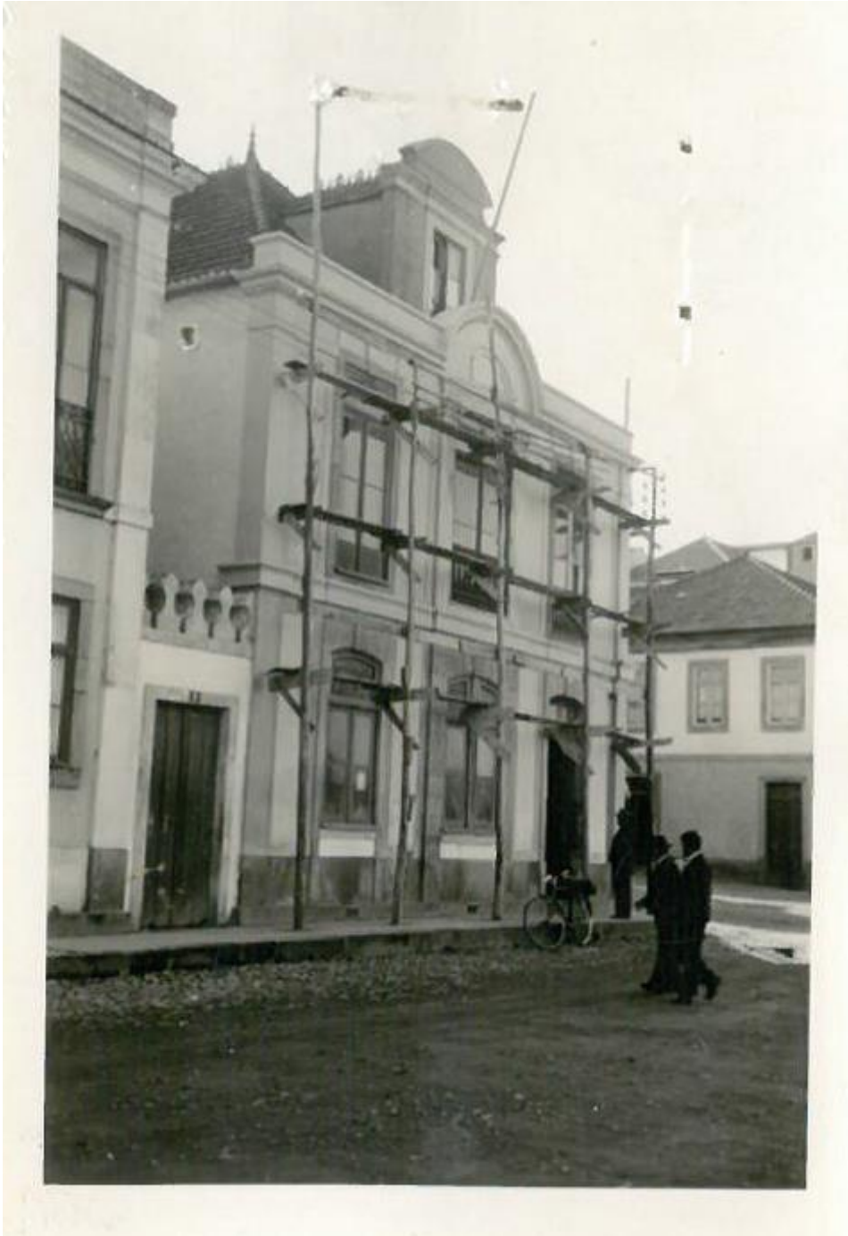
Figura 1 - Filial da Caixa Geral de Depósitos, Crédito e Previdência (CGDCP), em Aveiro. Obras de conservação.
