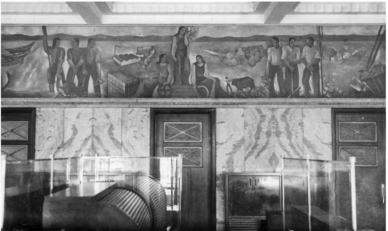
Interior da agência de Póvoa de Varzim, sala do público, sendo visível a pintura de Júlio Santos [década de 1930]. Processos de obras. AHCGD (piso -4).
