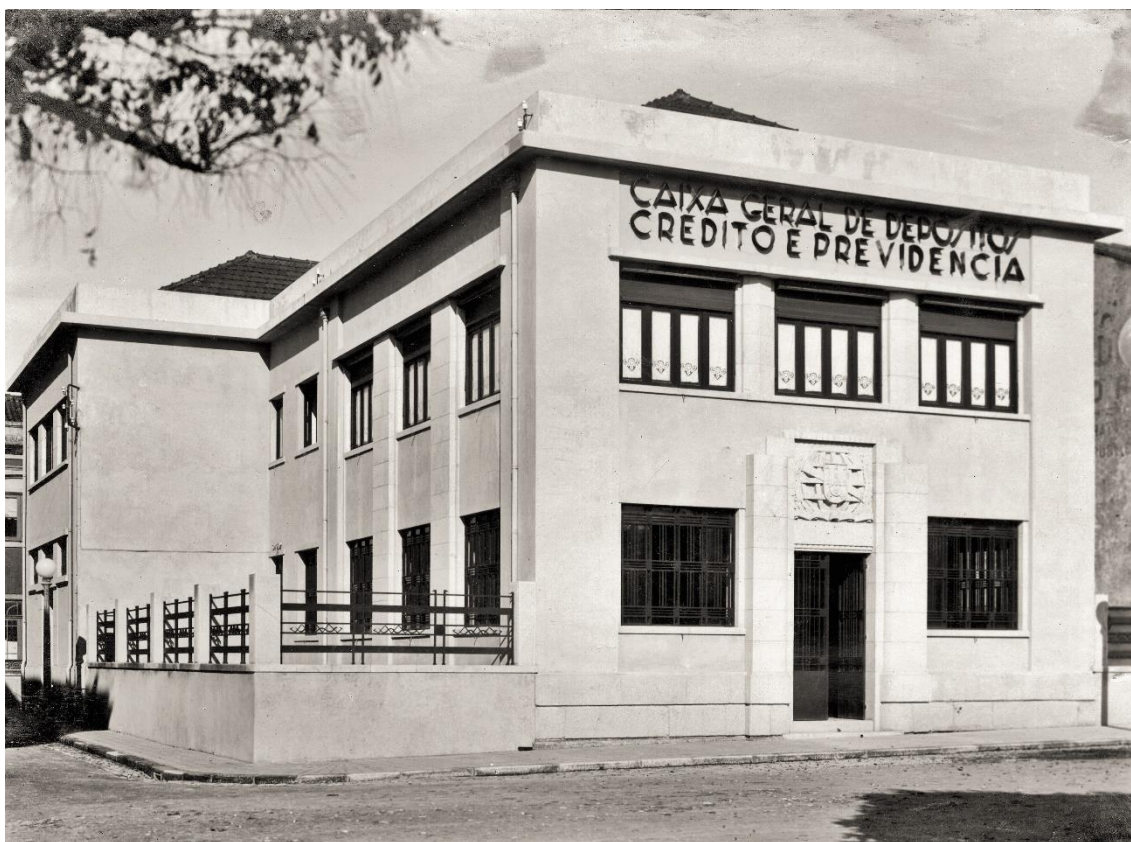
Edifício da agência de Póvoa de Varzim, após conclusão [década de 1930]. Processos de obras. AHCGD (piso -4).
