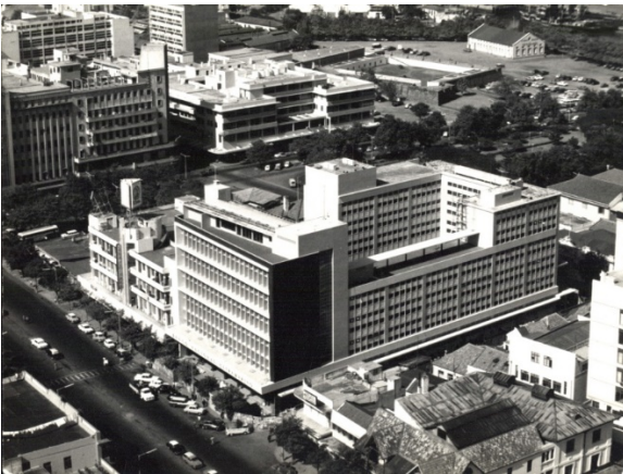
07 – Vista aérea do edifício da Diretoria do BNU em LM, entre 1964-1975. Vista do alçado para a Av. da República. Foto datada de c. 1970. [AHCGD BNU/1AF/02AG/12.01-18]
