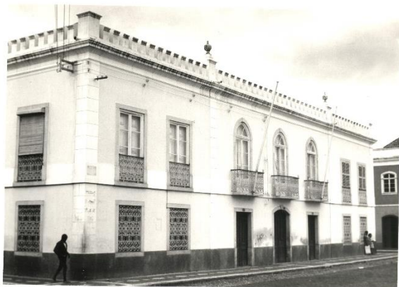
01 – Edifício da filial do BNU Santiago. Fachada para Praça Infante D. Henrique. Cerca de 1950.
