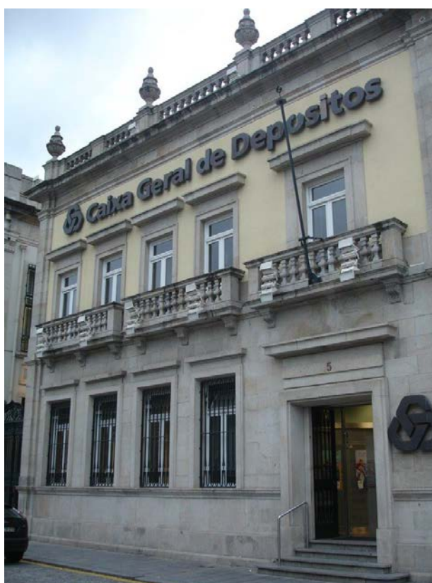
Fotos 5 e 6 – Edifício da Filial da CGD, em Braga (2015)
